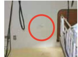
ベッド、キャスター機器の移動により壁が損傷
