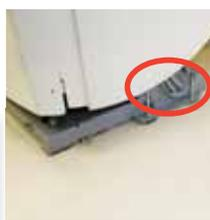
重量のある機器類は、アンカーボルトを用いて床や壁に直接固定します。また、固定位置のバランスが悪いと固定ボルトが地震動で抜けてしまうこともあるので注意が必要です。
