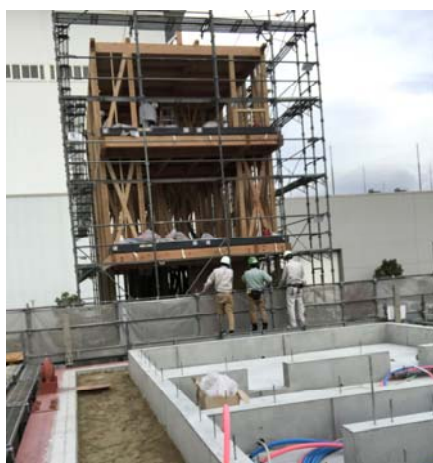
写真 地盤上のべた基礎 注4 施工状況
